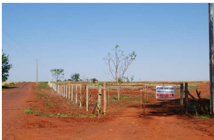
Figura 28: Aterro Sanitário de Serranópolis do Iguaçu
