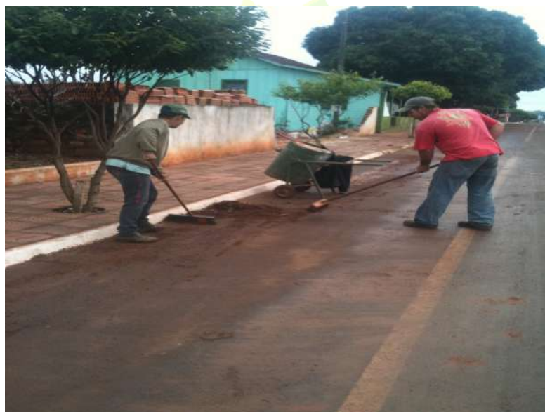
Figura 17: Execução de varrição na área urbana
