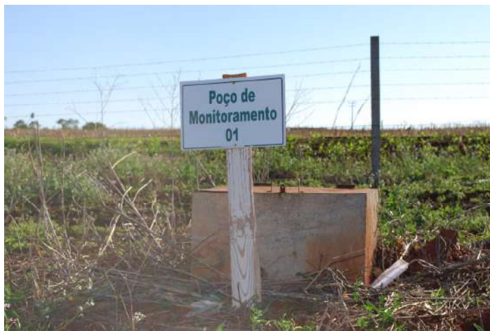
Figura 27: Poço de Monitoramento do aterro sanitário
